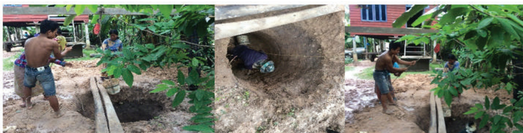
Status på gravearbejdet med ring-brønde i Koukthlok village Koukthlorkleu Commune, Chikreang District
