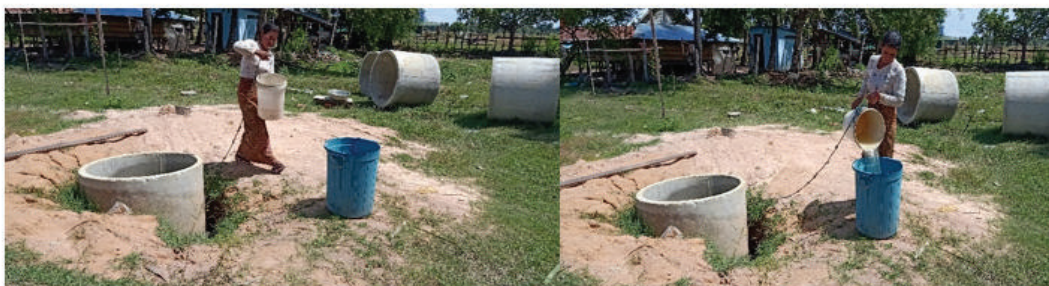
Status på udgravning til ringbrønd i Chub Village, Chansar Commune, Sotrnikom District
